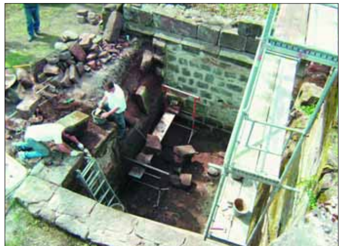
Travaux au fossé d'entrée en 2010 (ph. Marc Schampion)
