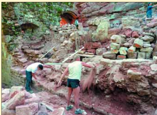
Purge du rempart Est en 2012
