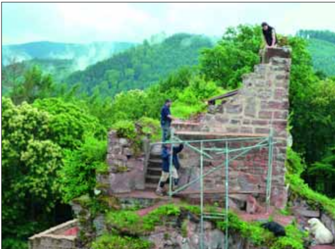
Le rocher Sud, démontage de l'échafaudage en 2012 (photo : Marc Schampion)
