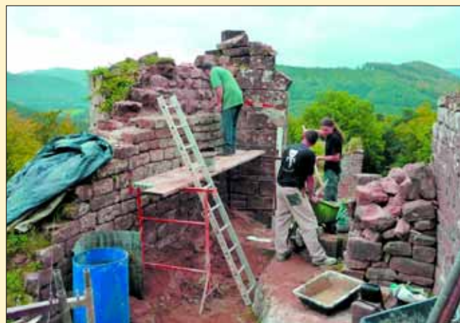
Le rocher Nord, remontage du mur en 2011
