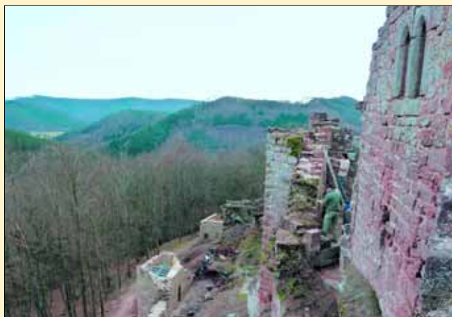
Le rocher Nord, jointoyage du mur en 2012
