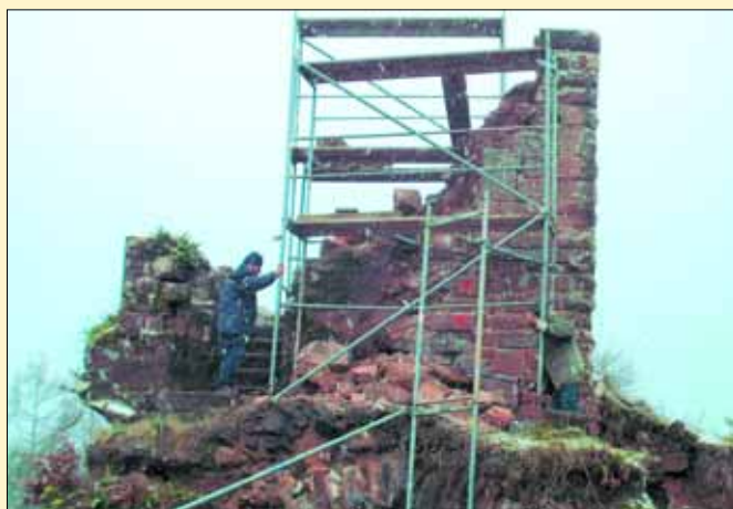
Le rocher Sud, installation de l'échafaudage sous la neige en 2011 (ph. Delphine Audibert)
