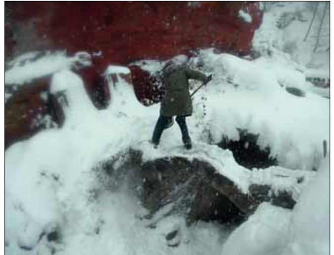
Dégagement de l'arcade qui sera déposée, consolidée et remontée en 2010 (ph. Patrick Claude)
