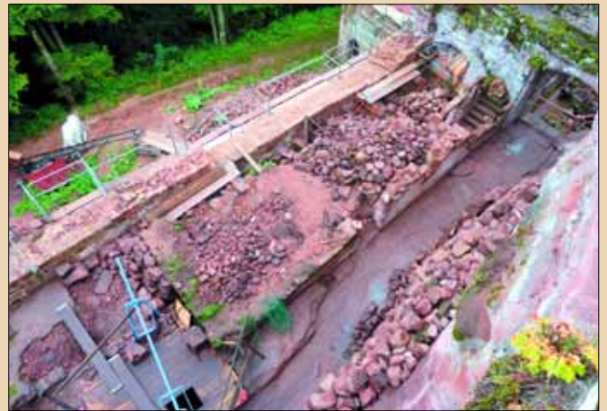
Vue d'ensemble du chantier en octobre 2012 (ph. Marc Schampion)
