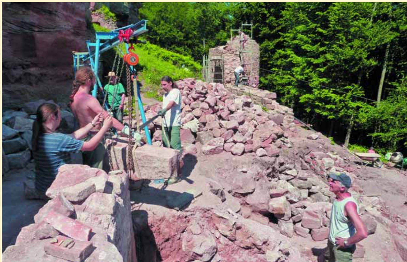
Levage d'une pierre grâce à la chèvre en 2012 (photos Marc Schampion)
