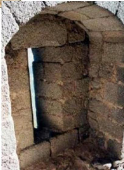
L'utilisation des meurtrières a été pensée dans les moindres détails, pour améliorer au maximum leur efficacité. Au lieu de simplement les percer dans les murs, on a prévu de les placer dans des niches de tir.
